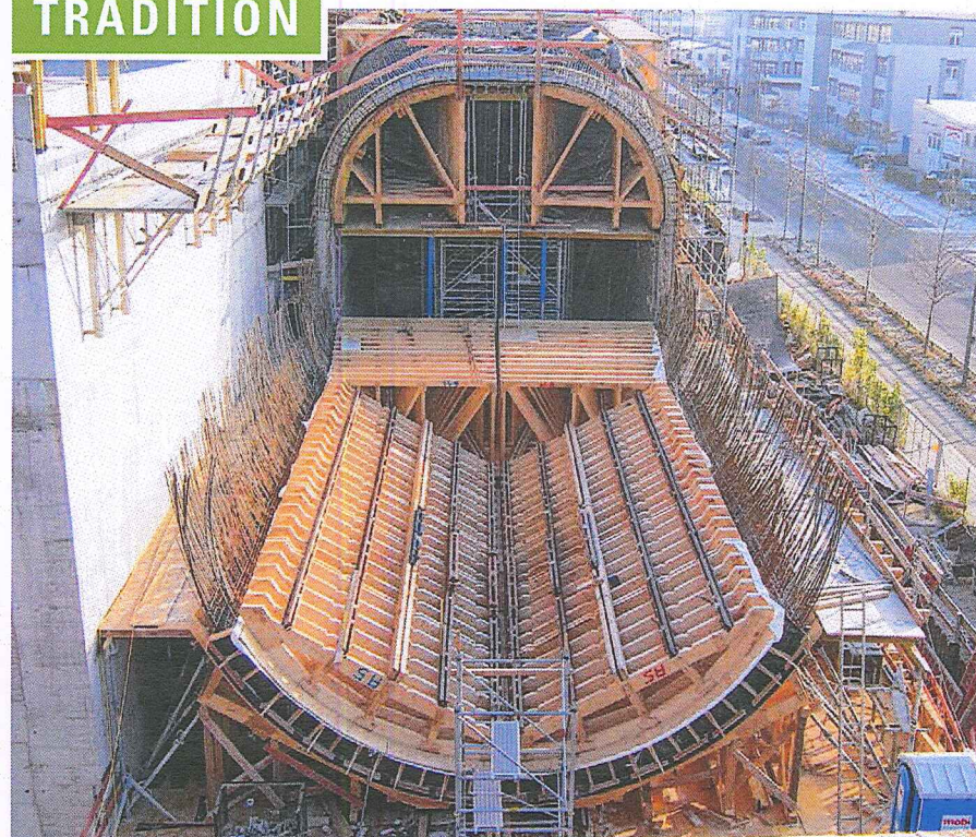
Unternehmensbereich Holzbau: Sonderschalung für das Aerodynamische Versuchszentrum AVZ, BMW AG, München
