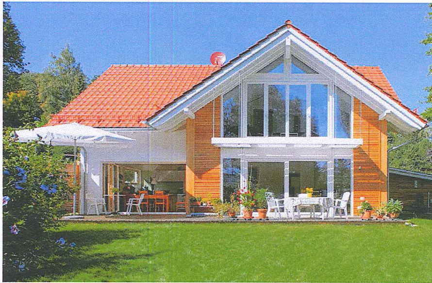
Unternehmensbereich Holzbau: Holzhaus mit Holzmassivwand und Holz-Alu-Fenstern.
